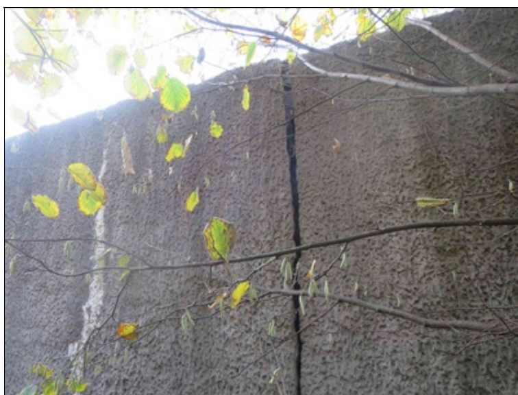
DTTO - separace pokračuje i na líc parapetní zdi
