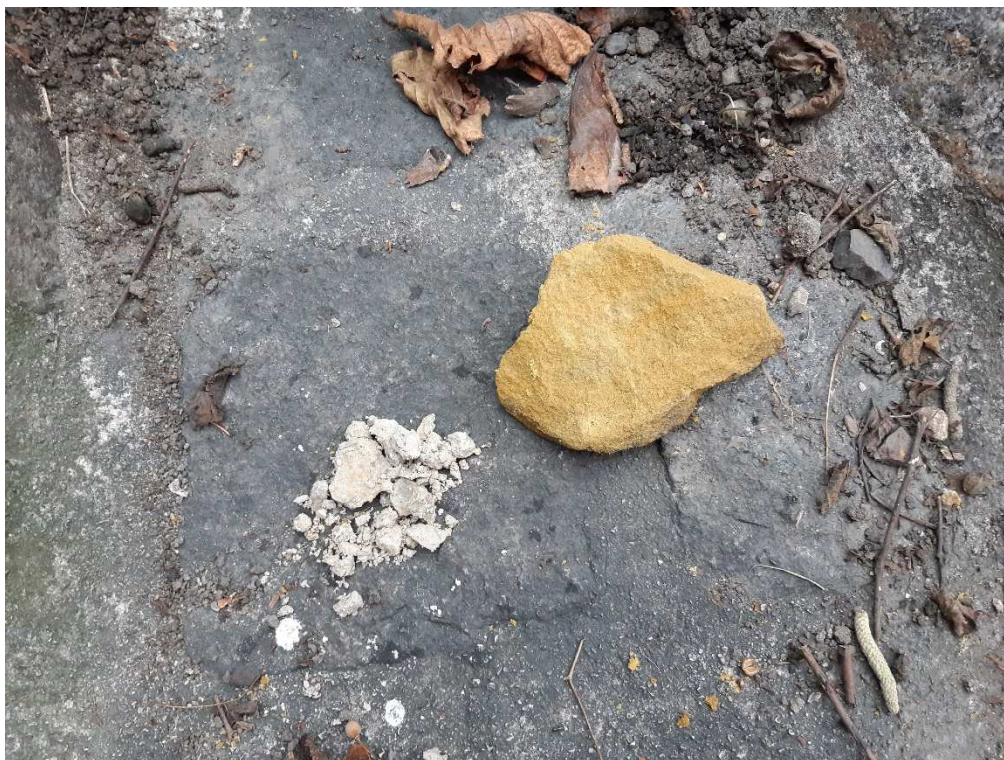
Foto č. 10 – Detail odstraněného kamenného zdiva nosné konstrukce.
