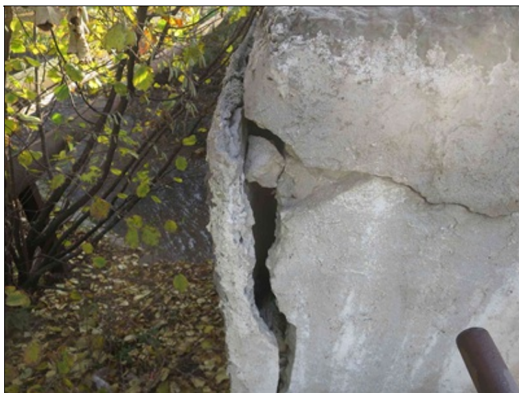
separace torkretu z líce zdiva zábradelní zídky
