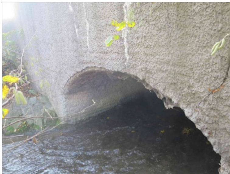
pohled na levý bok - v hraně klenbového pasu opět pokračuje separace torkretu od zdiva
