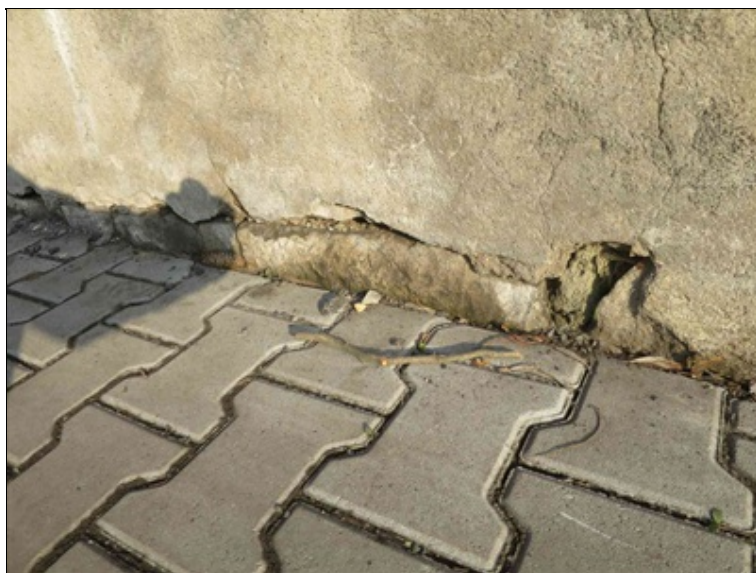
v oblastech obnaženého zdiva parapetní zídky jsou patrné poruchy spárování zdiva
